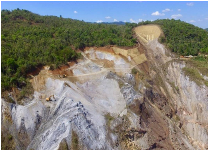
Durante a obra - Regularização das erosões
