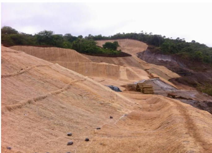
Durante a obra - Aplicação dos retentores de sedimentos Bermalonga®
