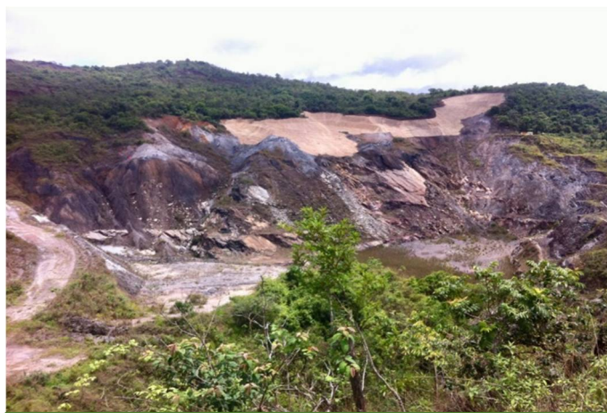
Durante a Obra
