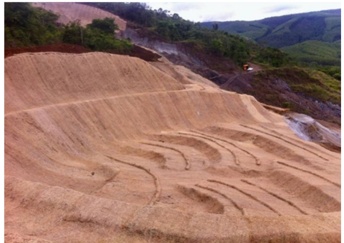
Durante a obra - Aplicação das Biomantas Tela Biotextil © 400UF
