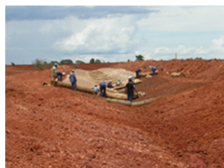
Durante a obra – Regularização das canaletas
