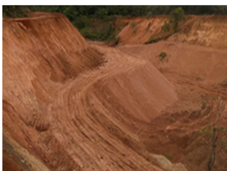
Durante a obra – Regularização das erosões
