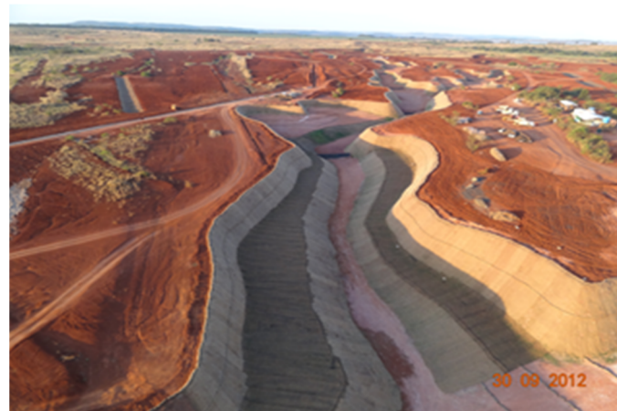
Durante a Obra
