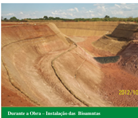
Durante a obra – Regularização das erosões
