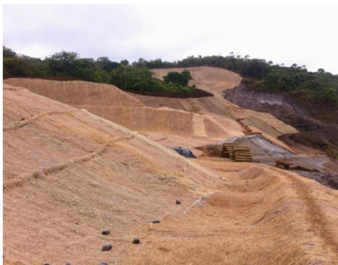
Durante a Obra: Aplicação dos Retenedores de sedimentos Bermalonga®
