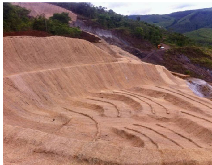
Durante a Obra: Aplicação das Biomantas Tela Biotextil® 400UP
