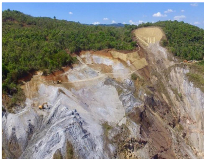
Durante a Obra: Regularização das Erosões
