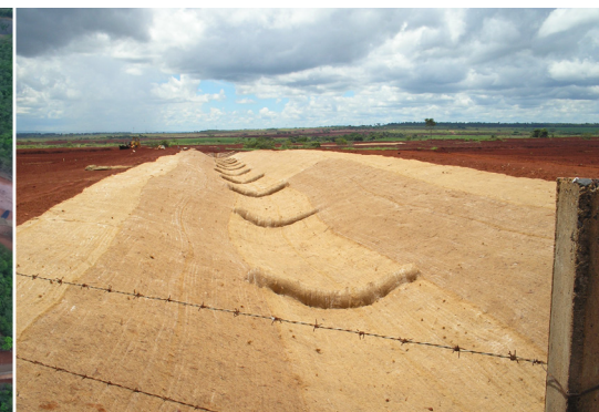
Biomanta e retentores aplicados
