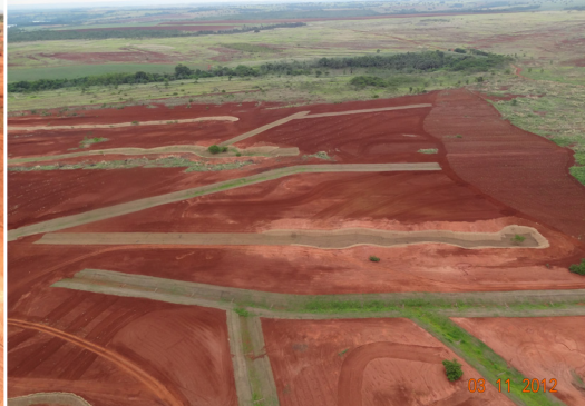
Abertura das canaletas verdes
