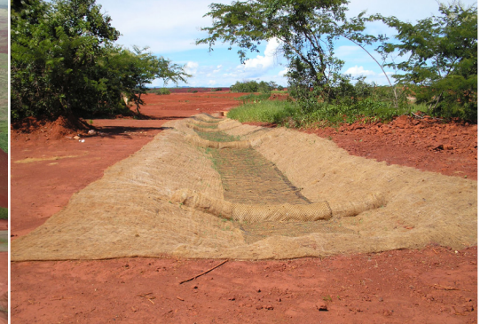
Regularização de canaletas
