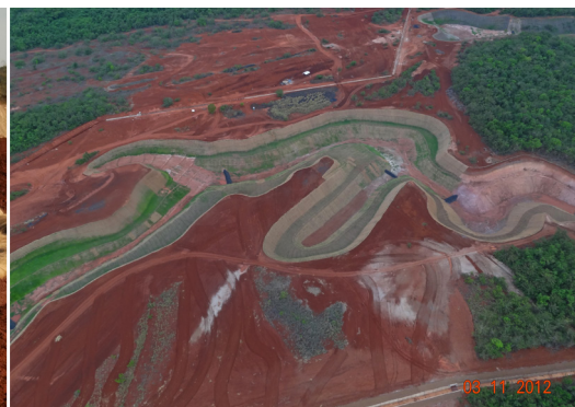
Biomantas aplicadas nas canaletas
