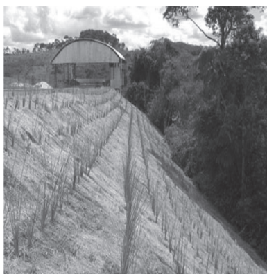
Foto 2 – Atiramento verde com biomanta antierosiva e vetiver de aterro sem compactação e em apenas 30 dias, protegem o talude, pois não houve trincas, carreamento de sedimentos e erosões.
