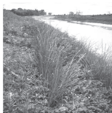
Foto 3 – Proteção de margens de curso d'água com barreiras vivas de vetiver em consorciação com gramíneas e leguminosas e biomanta antierosiva de proteção definitiva.
