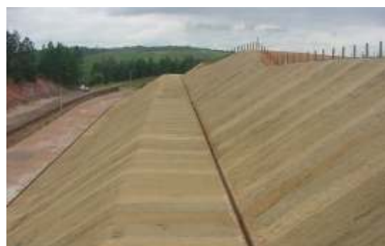
Drenagem e biomantas antierosivas aplicadas em taludes de corte
