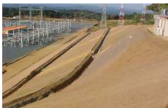
Taludes já protegidos com biomantas antierosivas
