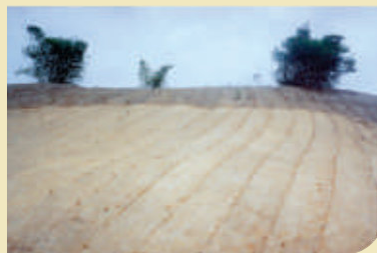
3. Mesmo local imediatamente após a execução dos serviços, mostrando o aspecto visual e proteção total da superfície dos taludes.
