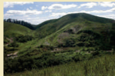
3. Mesmo local após três meses da execução dos serviços, vê-se a eficiência do método, nenhum foco erosivo e a área completamente revegetada.
