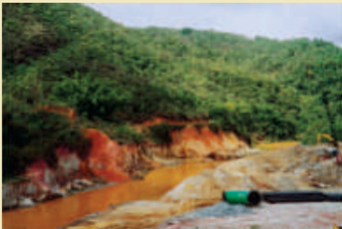
1. Talude erodido de curso d'água adjacente à construção da Casa de Força de Usina Hidrelétrica, necessitando de proteção.
