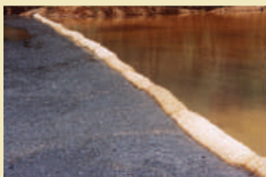
4. Retenção de óleo com barreira de retentores de sedimentos (Bermalonga® D40).
