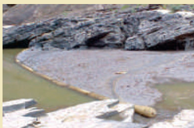
1. Detalhe da eficiência da retenção dos sólidos em suspensão e a ancoragem com Bermalonga® nas margens do curso d'água.
