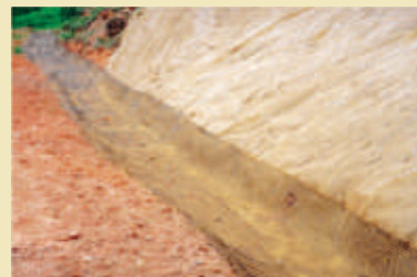
3. Canaleta de drenagem superficial revestida com Tela Sintemax® 400TF.
