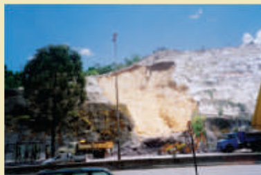
2. A técnica utilizada para a contenção foi o solo grampeado verde, com uso de biomanta antierosiva de fibra de coco bidimensional (Tela Fibrax® 400BF).
