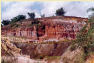
1. Vista geral das erosões, as quais serão recuperadas com uso das Técnicas de Bioengenharia e produtos biodegradáveis.
