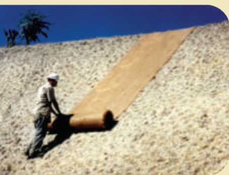
Aplicação da biomanta: o aplicador desce desenrolando a biomanta e executando o grampeamento, mantendo-a sempre rente ao solo.
