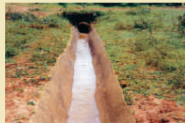
6. Canaleta de drenagem superficial revestida com biomanta antierosiva de fibra de coco tridimensional (Tela Sintemax® 400TF).
