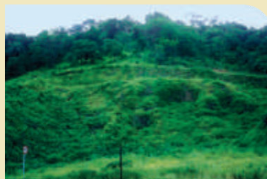
3. Mesmo local após três meses de aplicação das biomantas antierosivas, totalmente recuperada e sem focos erosivos, apresentando vegetação exuberante.
