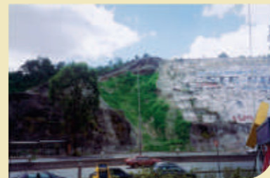
3. Mesmo local após a execução da técnica, mostrando a eficiência e melhoria do visual, além dos aspectos ambientais, como infiltração da água, atenuação da radiação e redução da temperatura.
