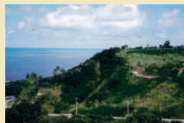
3. Vista do mesmo local, um ano após as medidas de contenção serem executadas, com utilização das Técnicas de Bioengenharia.
