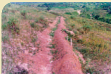
1. Drenagem superficial, aplicada transversalmente à inclinação do talude, utilizando Bermalonga® D40 e Tela Fibratêxtil® 400BM.
