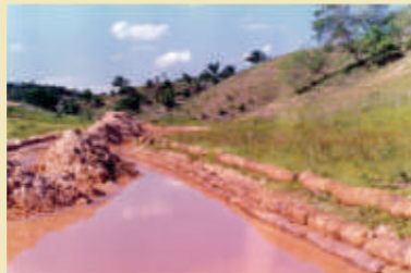
2. Trabalho já em fase adiantada, final do processo de desassoreamento e proteção das margens com uso de retentores de sedimentos, tipo Bermalonga® D40.
