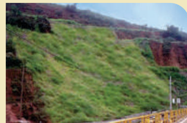
3. Mesmo local, três meses após a recuperação e proteção do talude, já totalmente revegetado e isento de focos erosivos.
