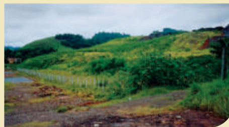
3. Mesma área já totalmente recuperada, mostrando a melhoria do visual e ausência de focos erosivos e sulcos.
