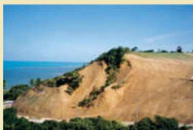
2. Vista do local após a aplicação da Tela Vegetal® 1000LC, a diferença do aspecto visual logo após a aplicação da mesma.
