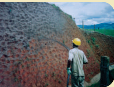
Preparo do solo - coveamento e hidrossemeio
