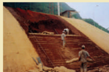
3. Preenchimento e recuperação do talude erodido com Bermalonga® D20, formando um rip-rap, e aplicação de solo compactado.
