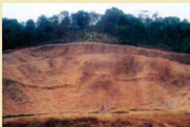
2. Biomanta Antierosiva aplicada após outras intervenções de Bioengenharia, mudando imediatamente o aspecto visual do local.
