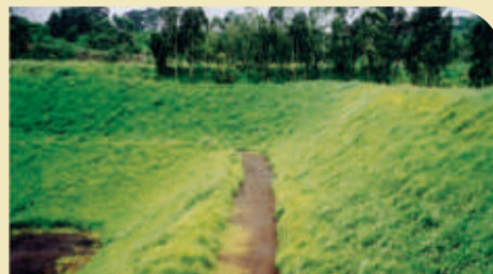
3. Vista da mesma área após o desenvolvimento da vegetação, dando aspecto de que na área nunca houve interferência humana, mesmo após várias chuvas, permanecendo com total ausência de sulcos erosivos, protegendo totalmente a área.
