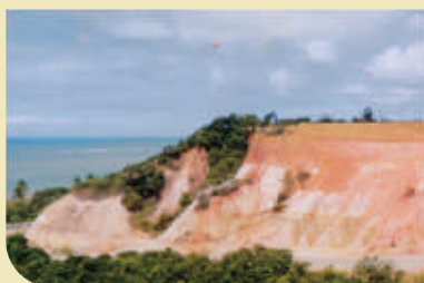
1. Talude totalmente erodido, com ausência de vegetação, solo muito arenoso e facilmente erodível, necessitando de imediata proteção, a fim de evitar o aumento dos processos erosivos.
