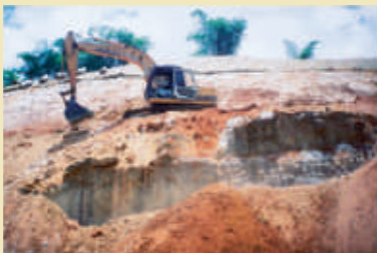
2. Serviços de recuperação já adiantados, com drenagem superficial e profunda executada, recuperação das erosões e aplicação de biomanta.
