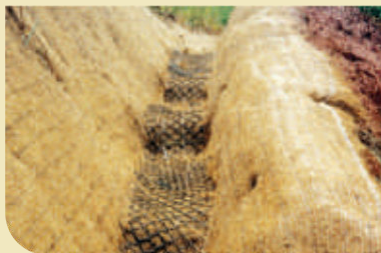
4. Descida d'água revestida de Sintemax® com proteção nas áreas adjacentes com biomanta antierosiva tipo Tela Biotêxtil® 500BP, para evitar que a água penetre atrás da canaleta.
