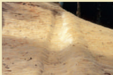
2. Canaleta de drenagem superficial, revestida com Tela Fibrax® 400BF.
