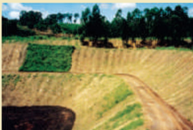
2. A área verde na foto foi o teste piloto, e após o cliente ter certeza do resultado, foi aplicada a biomanta antierosiva tipo Tela Biotêxtil® 600BP, em toda a superfície dos taludes.
