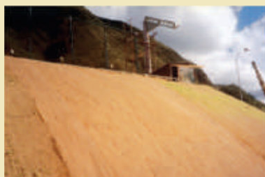
5. Proteção superficial do talude erodido, já recuperado com biomanta antierosiva de fibra de coco bidimensional (Tela Fibrax® 400BF), sobre o rip-rap de Bermalonga®.
