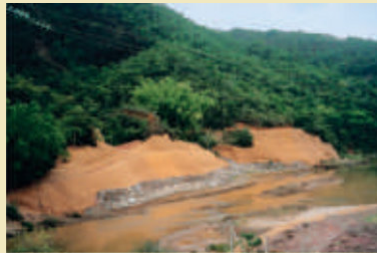
2. Mesmo local já protegido com biomantas antierosivas de alta resistência e longevidade, mostrando o talude já recuperado e protegido.
