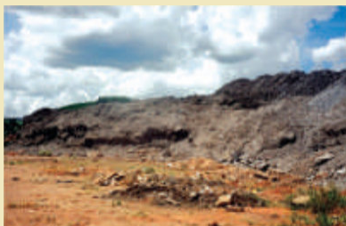
1. Área de resíduos industriais que será recuperada com o uso de duas camadas de biomantas antierosivos, drenagem e vegetação.
