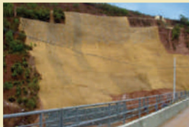
2. Mesmo talude, já recuperado e protegido com a técnica de solo grampeado verde e biomantas antierosivas.
