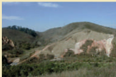
2. Serviços de recuperação já adiantados, com drenagem superficial e profunda executada, recuperação das erosões e aplicação de biomanta antierosiva.
