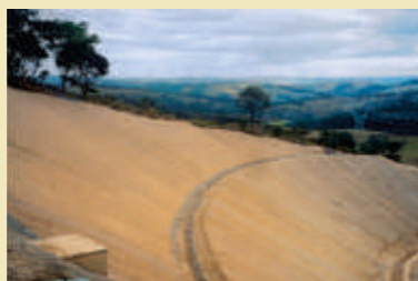
2. A proteção dos taludes foi feita com biomanta antierosiva de fibra de coco bidimensional (Tela Fibrax® 400BF), protegendo imediatamente a área até o estabelecimento total da vegetação.
