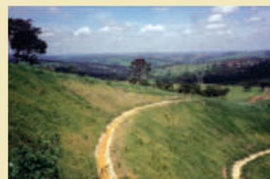
3. Resultado do trabalho, mostrando toda a área protegida, o estabelecimento da vegetação e a ausência de sulcos e focos erosivos.
