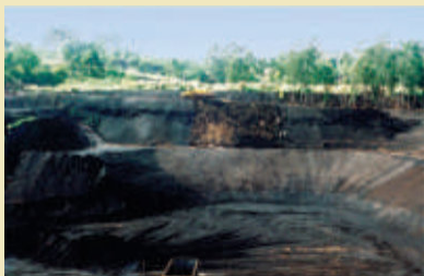
1. Vista geral de resíduos industriais, iniciando o preparo do solo, material de grande suscetibilidade à erosão e muito estéril, chegando a atingir altas temperaturas no verão.
