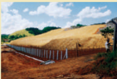
2. Após a aplicação de solo na camada de 10 cm, foi feita a hidrossemeadura e aplicação de uma segunda camada de biomanta antierosiva de fibra de coco unidimensional.
