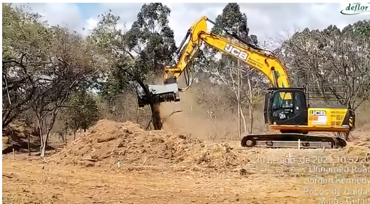
Figura 6 — Triturador em operação, triturando árvore isolada com diâmetro maior que 40cm acoplado em escavadeira hidráulica de peso operacional de 20 toneladas.
