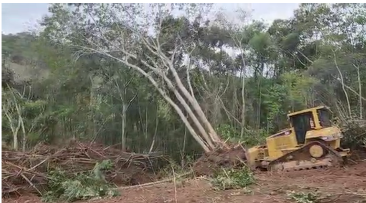
Figura 1 — Derrubada com trator de esteiras (D6N) em área acidentada.
