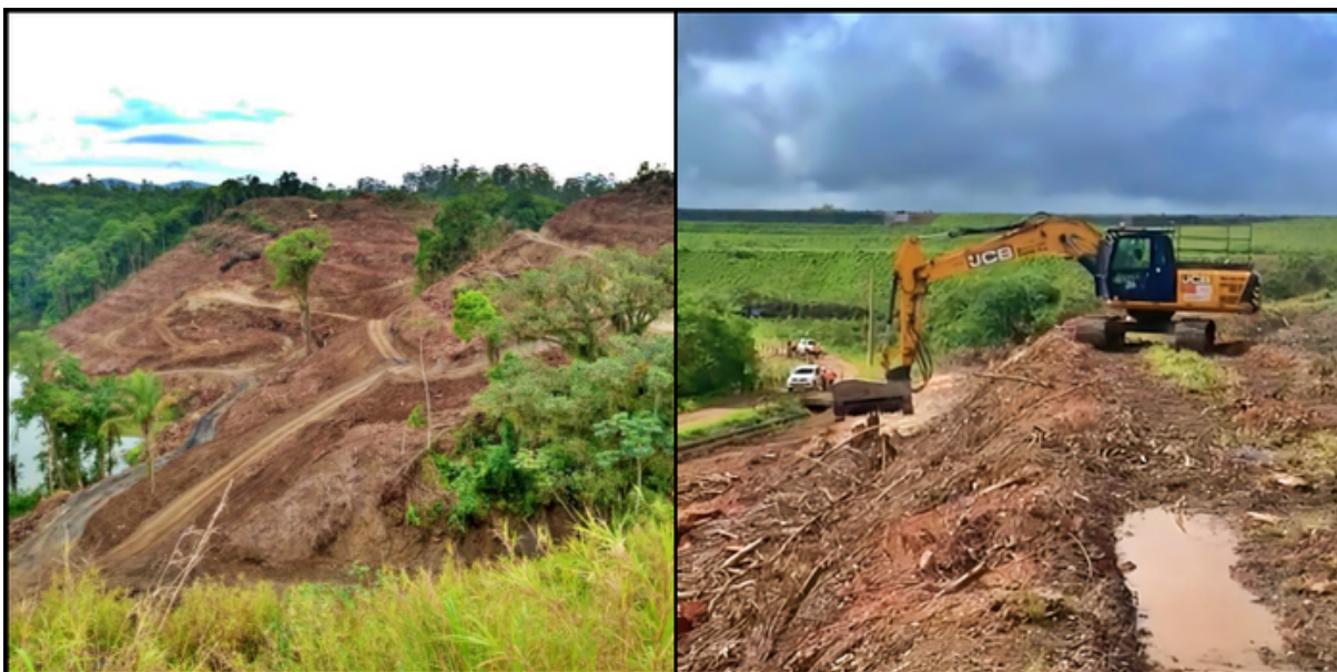
Figura 7 — Área de grande inclinação, onde a floresta foi triturada totalmente, mostrando os acessos feitos por escavadeira hidráulica, e a área totalmente limpa.
