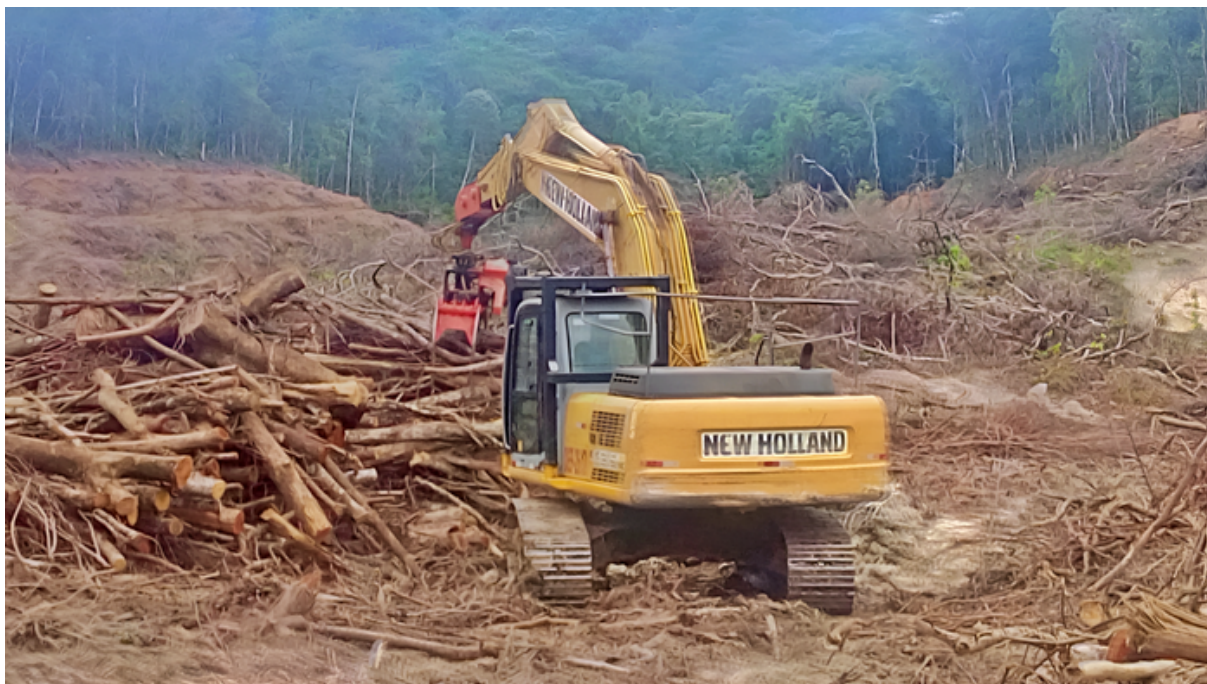
Figura 9 — Garra traçadora em operação acoplada em escavadeira hidráulica de 21 toneladas.
