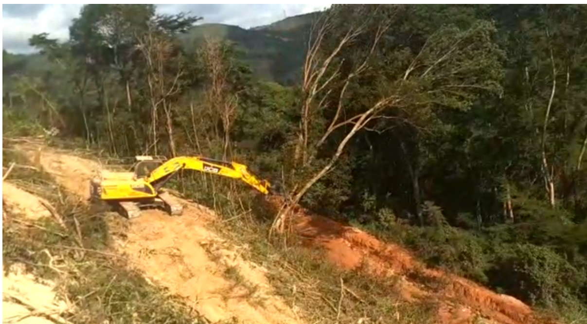
Figura 2 — Escavadeira hidráulica de peso operacional de 20t em floresta nativa em área inclinada
