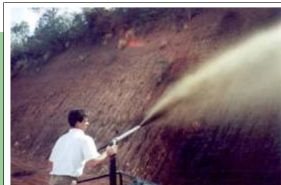
Aplicação de hidrossemeadura com utilização de bomba e caminhão hidrossemeador
